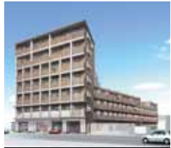
ベラジオ京都清水 平成18年8月竣工
