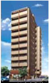
ベラジオ烏丸御池 平成13年12月竣工
