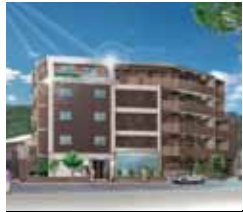
ベラジオ嵐山 平成20年3月竣工
