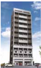
ベラジオ四条大宮 平成20年3月竣工
