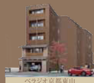
ベラジオ京都東山 平成23年7月竣工
