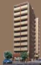
ベラジオ烏丸御池 平成13年12月竣工
