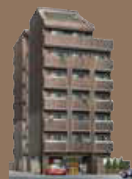
ベラジオ五條烏丸 平成16年2月竣工
