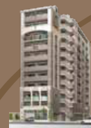
ベラジオ四條烏丸 平成14年6月竣工
