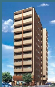
ベラジオ鳥丸御池 平成13年12月竣工
