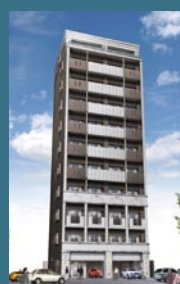
ベラジオ四条大宮 平成20年3月竣工
